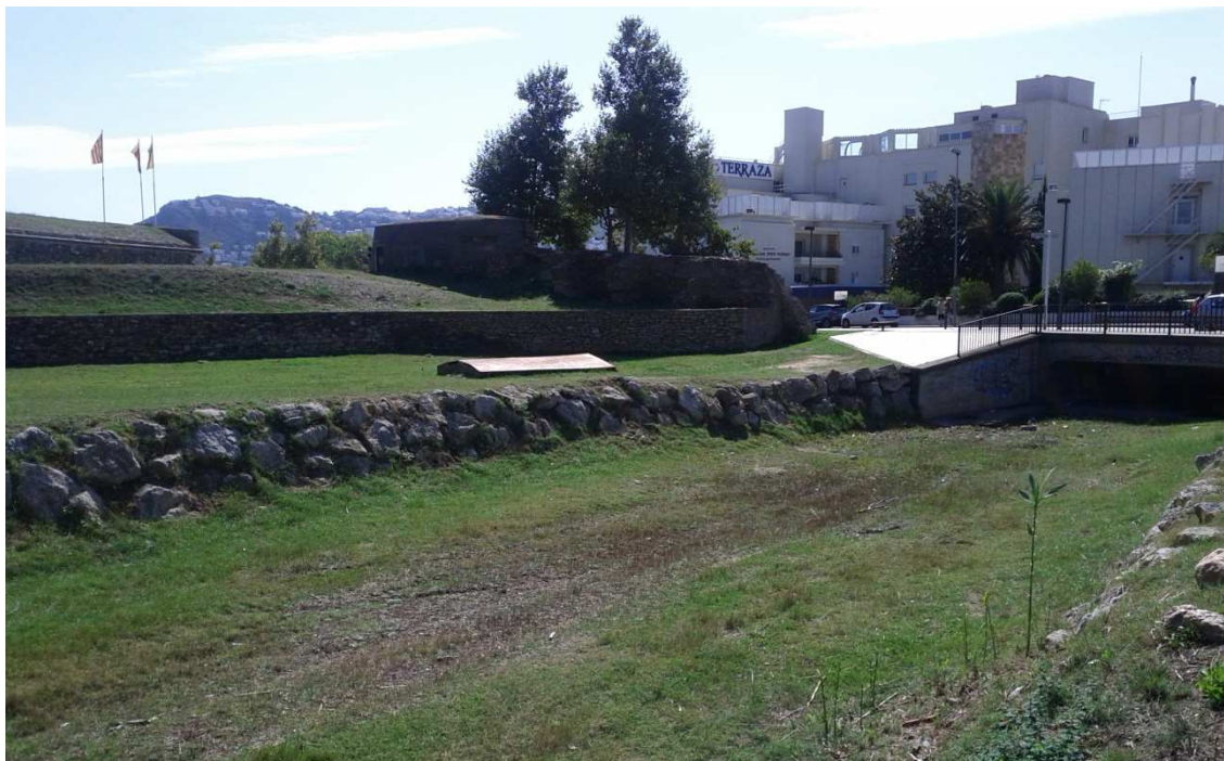
Foto 5: Vista del tram final de l'actuació des del marge dret de la riera Trencada. Al fons hi ha el pont de l'Avinguda de Rohde amb l'aleta de formigó que continua amb la protecció d'escullera. També es pot veure la coberta de la caseta de la Font de la Vituà, en la part central de la imatge.
